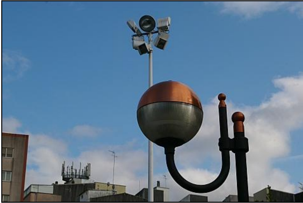
Na Praza de Pablo Iglesias conviven farois adecuados con focos inadecuados.
